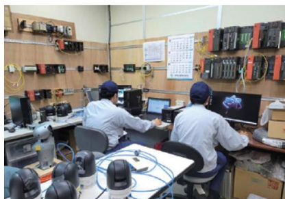
監視制御システム構築
