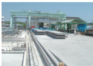
工場製造作業所
