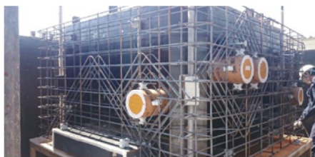
ボックスカルバート製造状況
