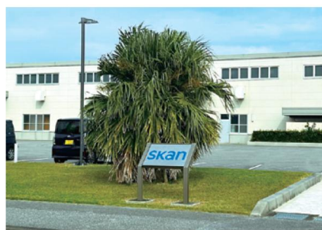
工場正面入口
