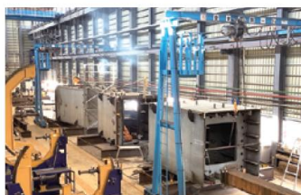
部材加工状況(第三工場内)
