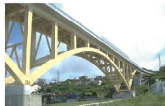
県道36号線橋梁整備工事
