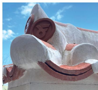
瓦・漆喰（施工後9ヶ月経過）
