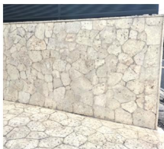
琉球石灰岩（施工後1年経過）
