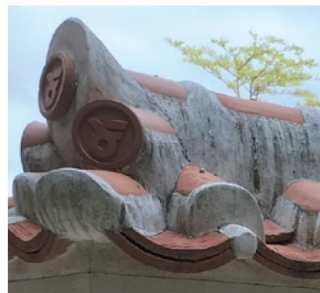
瓦・漆喰（施工前）
