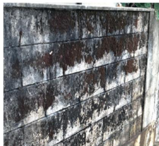
ブロック塀（施工前）
