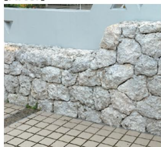
琉球石灰岩（施工後1年経過）
