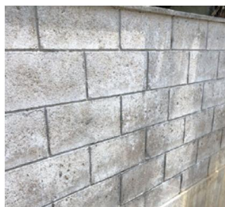
ブロック塀（施工後1年経過）
