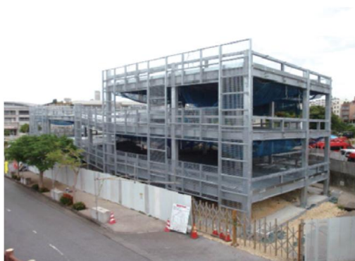
納入実績：那覇市内立体駐車場
