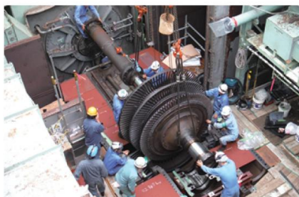
発電プラント工事
