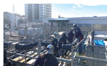
小型プラント設備施工
