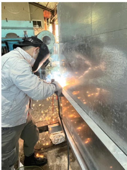
工場内作業 アーク溶接
