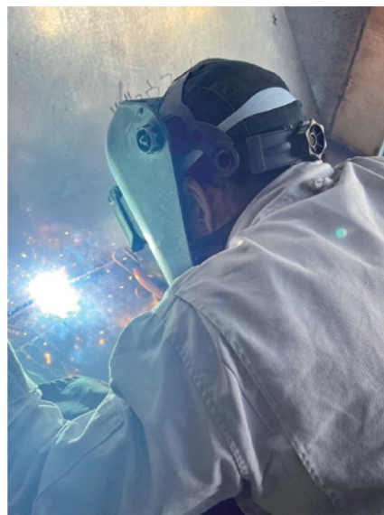
工場内作業 アーク溶接
