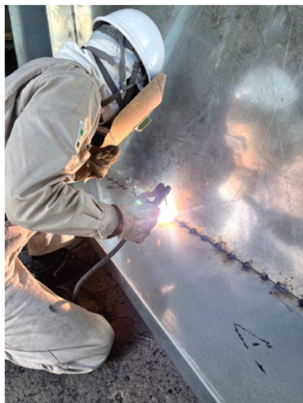
工場内作業 アーク溶接
